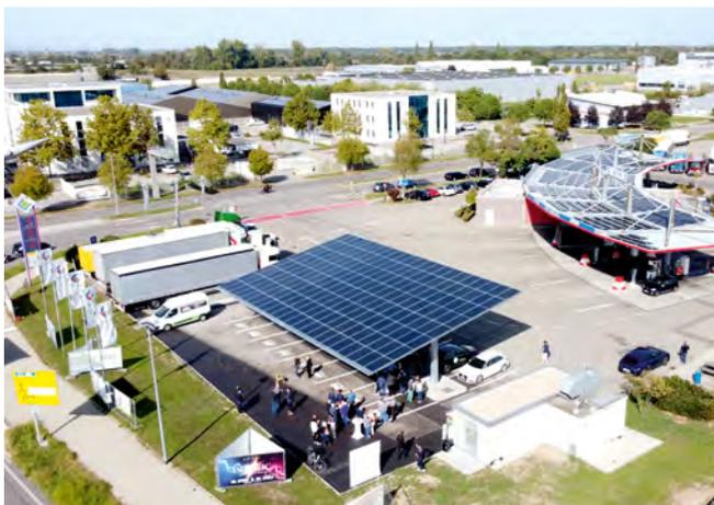
Der neue Ladepark von oben. Nicht nur hier, sondern auf allen großflächigen Dächern von Tankstelle, Lager und Lkw-Waschanlage der Fima Günther Energie+Service in Lahr wurde Photovoltaik mit insgesamt über 600 Kilowatt-Peak (kWp) Leistung installiert.
